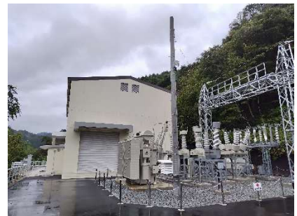
日野川第一発電所（外観）
