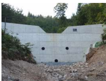
治山ダム（谷止工） （江府町 久連地区）
