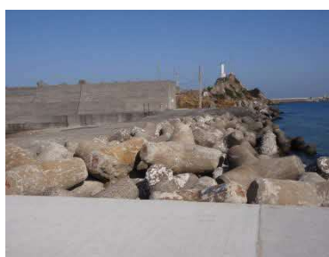
外郭施設 防波堤（鳥取港）
