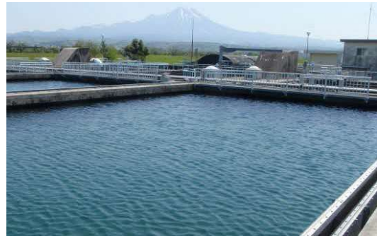
浄水場 [浄水施設] (日野川工水)
