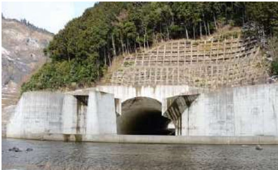
市瀬トンネル（L=230m）
