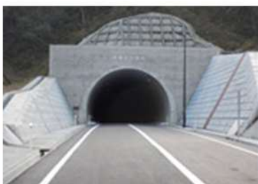
トンネル (日野溝口線 矢倉トンネル)
