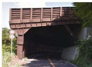
シェッド (倉吉江府溝口線 大内ロックシェッド)
