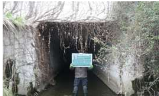
逆川トンネル（L=197m）
