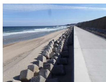
防潮護岸工 （湯梨浜町 はわい長瀬地区）
