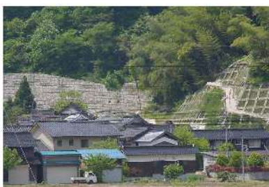
砂防設備 (大滝谷川、鳥取市)
