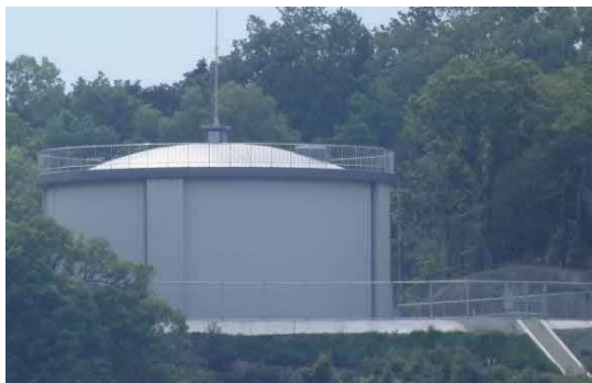
配水池 [配水施設] (鳥取工水)
