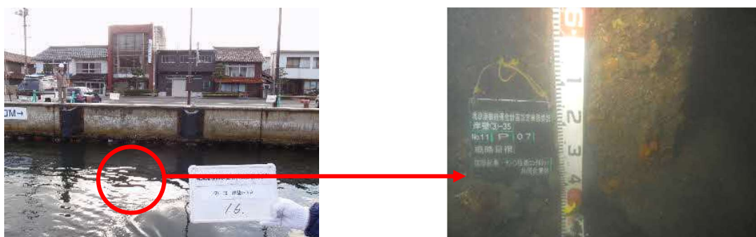
定期点検の状況
