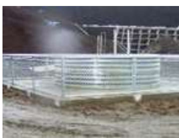
集水井工 （智頭町 大呂地区）
