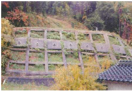
地すべり防止施設 焼杉地区（伯耆町）
