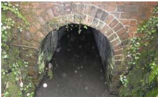
玉川トンネル（L=86m）
