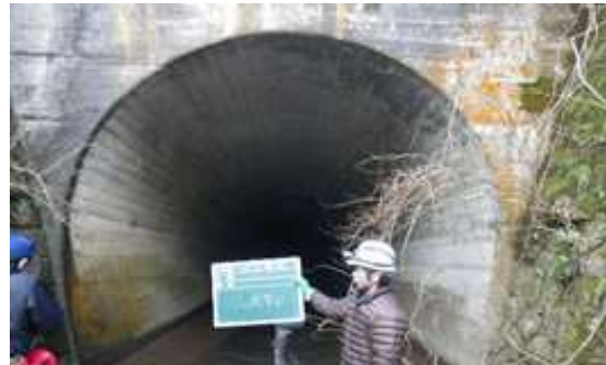
長瀬川トンネル（L=261m）
