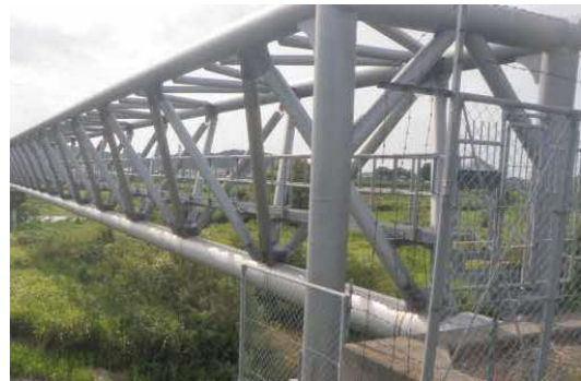
水管橋 [配水管] (鳥取工水)
