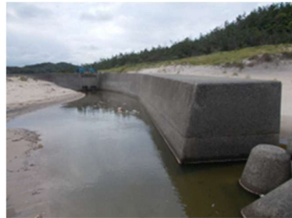
海岸保全施設 日光地区（鳥取市）
