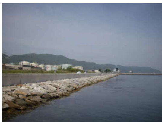
昭和南地区東側護岸
