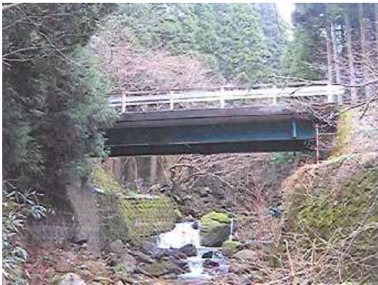
林道橋梁 坂ノ元線 1号基 (智頭町)
