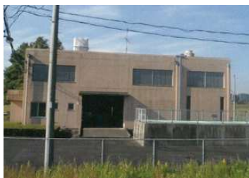
清水川排水機場
