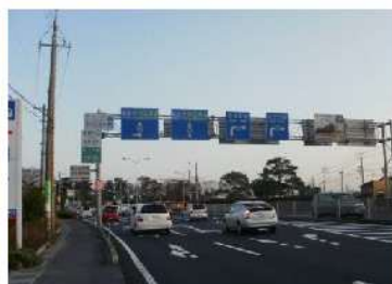
門型標識 (国道 431 号)
