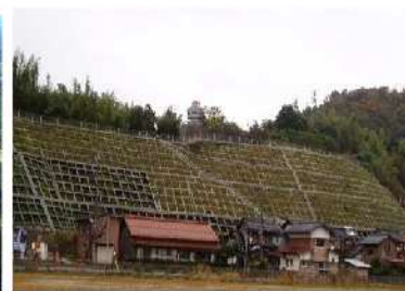
急傾斜地崩壊防止施設 (上橋津地区、湯梨浜町)
