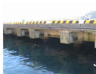
係留施設 岸壁（田後港）
