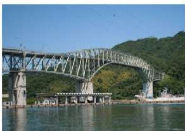
橋梁 (国道 431 号 境水道大橋)
