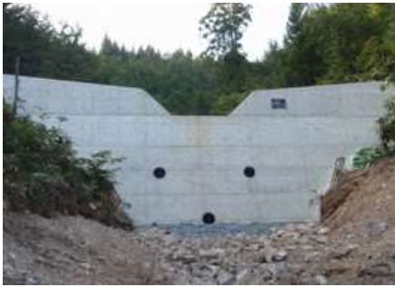
治山ダム（谷止工）（久連地区）
