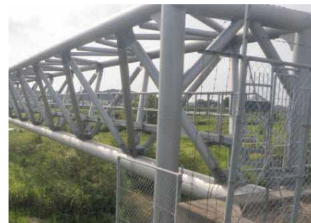
水管橋（鳥取工水）
