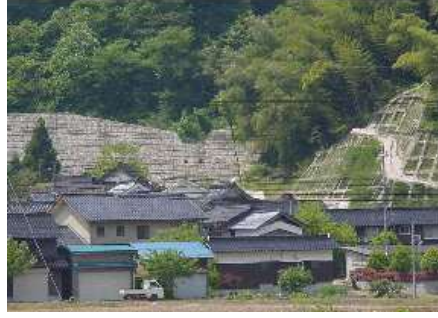
砂防えん堤（大滝谷川）
