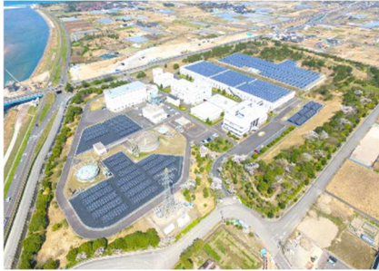
終末処理場（天神浄化センター）
