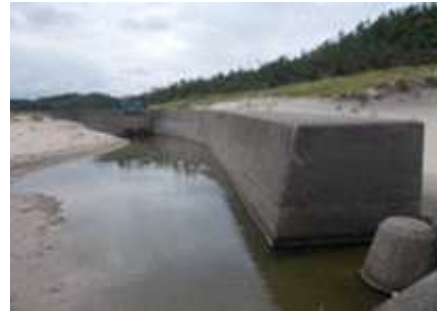
海岸保全施設（日光地区）
