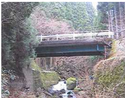
橋梁（内井谷線1号基）
