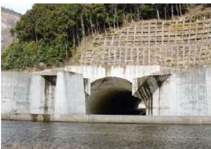
河川トンネル（市瀬トンネル）
