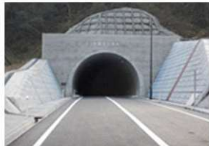
トンネル（日野溝口線 矢倉トンネル）
