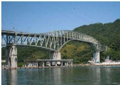
橋梁（国道431号 境水道大橋）
