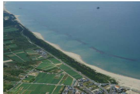
▲ 海岸保全施設(湯山海岸) 出典：鳥取県県土整備部資料
