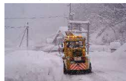
▲ 八頭県土整備事務所管内の除雪作業状況 出典：鳥取県HP
