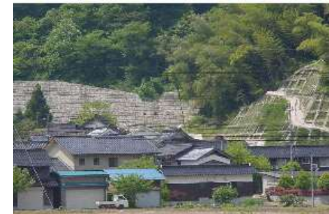
▲ 砂防えん堤(大滝谷川) 出典：鳥取県県土整備部資料
