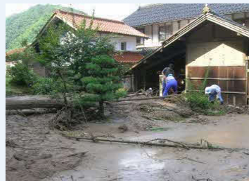
琴浦町上中村の被災状況
