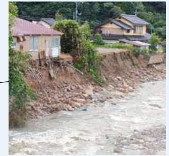
天神川 (三朝町久原) の被災状況
