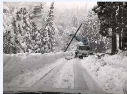
復旧作業の状況 (若桜町来見野)
