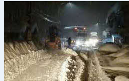
国道 373 号(智頭町大内地内)の除雪状況
