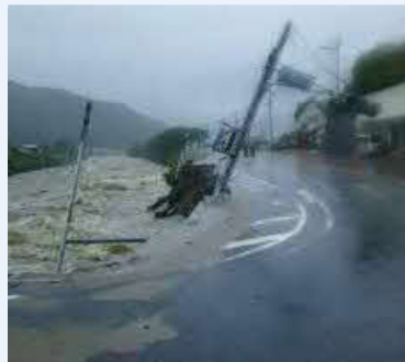
国道 373 号 (智頭町南方) の被災状況
