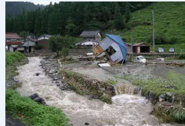
若桜町寺所(角谷川)の被災状況
