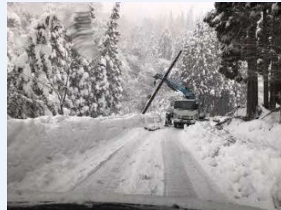
復旧作業の状況 (若桜町来見野)
