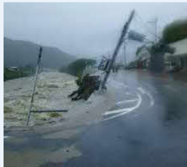
国道 373 号 (智頭町南方) の被災状況
