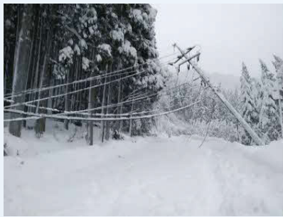
電柱倒壊の状況 (若桜町来見野)
