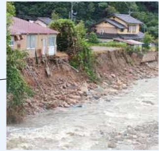
天神川 (三朝町久原) の被災状況
