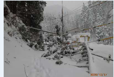
電柱倒壊の状況 (八頭町姫路)
