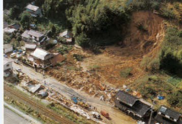
湯梨浜町方地の斜面崩壊
