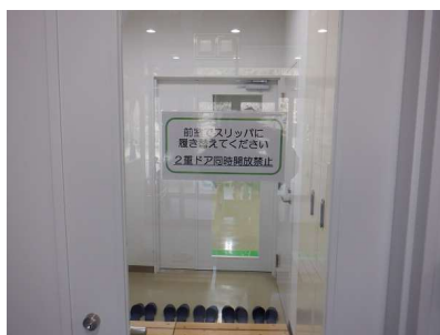
図5 前室出入口の改善状況 (専用スリッパ設置、注意書き表示)
