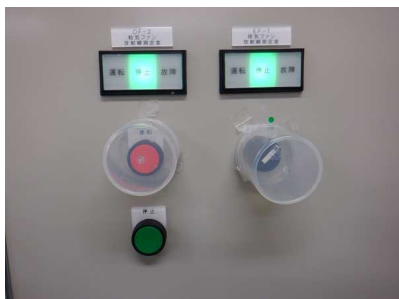
図4 操作盤への誤操作防止策
