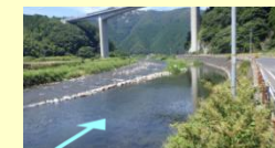
○石積の堰の補強による河川からの引水状況
