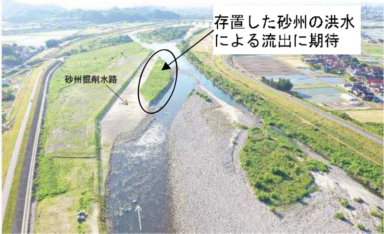
施工直後の航空写真
