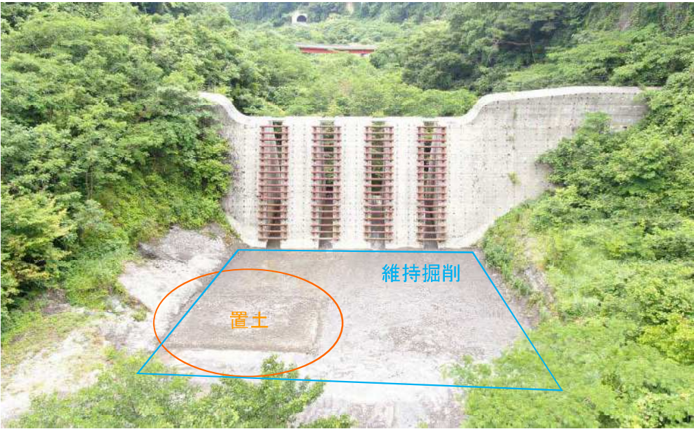
掘削+置き土の工事後(2023(令和5年).6)
