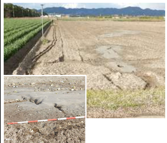
■潮廻し水路隣接農道の沈下
