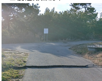
■農道路面沈下
