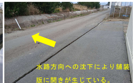
■潮廻し水路隣接農道の沈下
