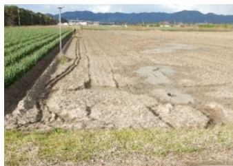
弓浜干拓地 水路の破損
