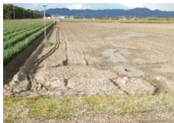
弓浜干拓地 水路の破損
