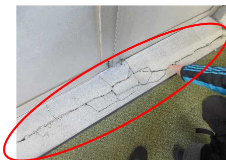
【就将小学校（米子市）】校舎ひび割れ
