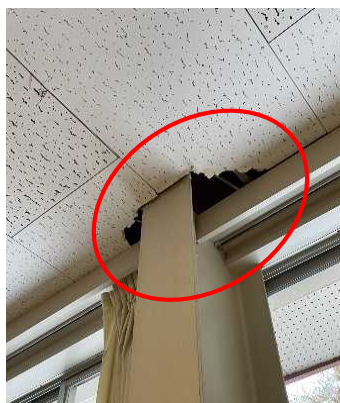
【法勝寺中学校（南部町）】 校舎天井パネルの一部落下
