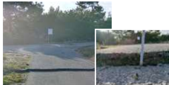
■農道路面沈下
