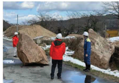
⑨ 町道溝口宇代線 落石 (伯耆町)
