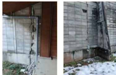
⑧ 県営ライフル射撃場 外壁亀裂 (南部町)
