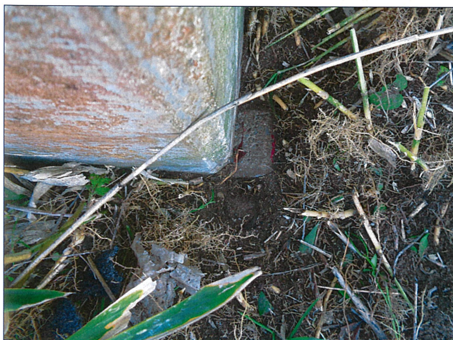
No. 3 標識: コンクリート杭 既存
