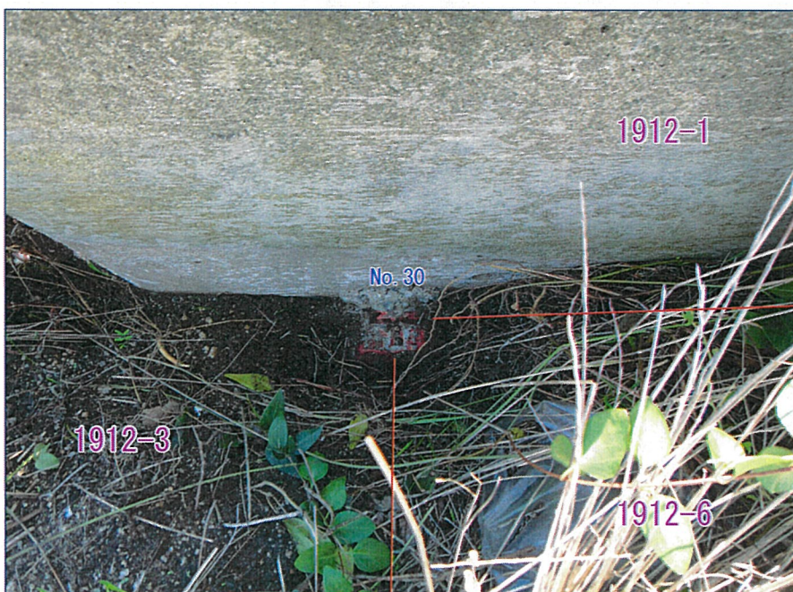
No. 30 標識: コンクリート杭 (既存)
