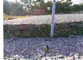
農道の沈下(弓浜)
