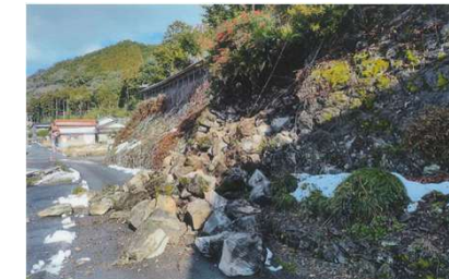
⑩ 町道上細見3号線 石垣崩落(伯耆町)
