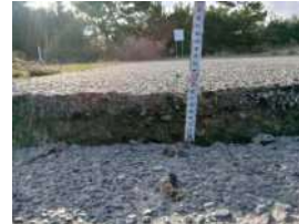
農道の沈下(弓浜)
