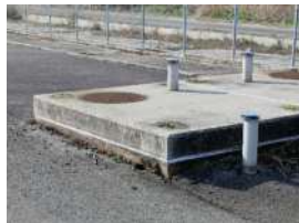
補水槽周り舗装沈下(彦名)
