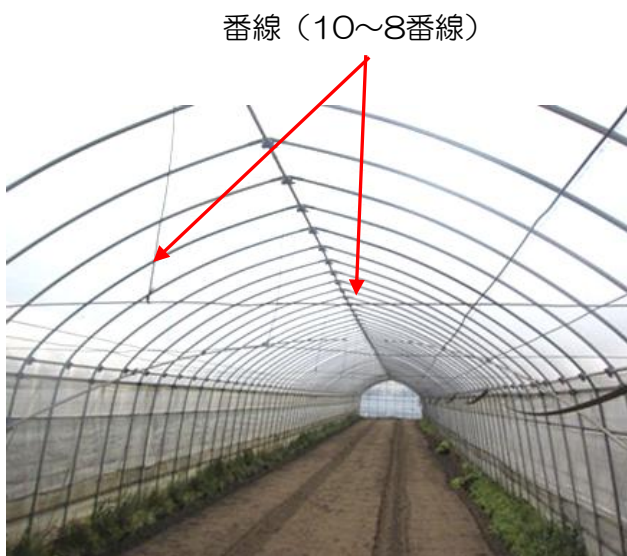
図16 水平引っ張り線による補強の例と番線を留めるワイヤークリップ (群馬県原図を一部改変)
