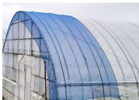
図26 妻面の防風ネットによる補強
