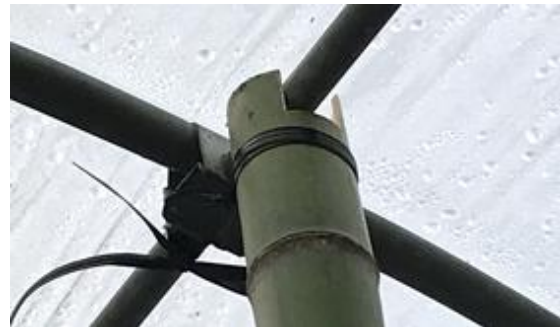
図14 中柱先端の加工と固定
