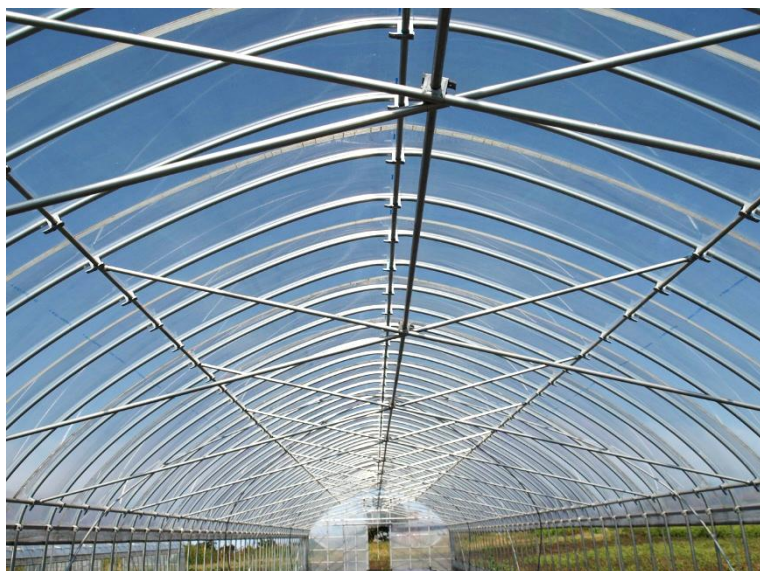
図8 Xタイバーによる補強の事例
