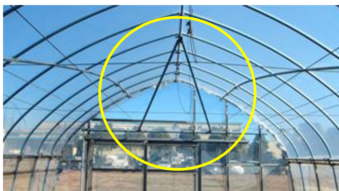
図24 逆V字方杖 (JA全農さいたま原図を一部改変)
