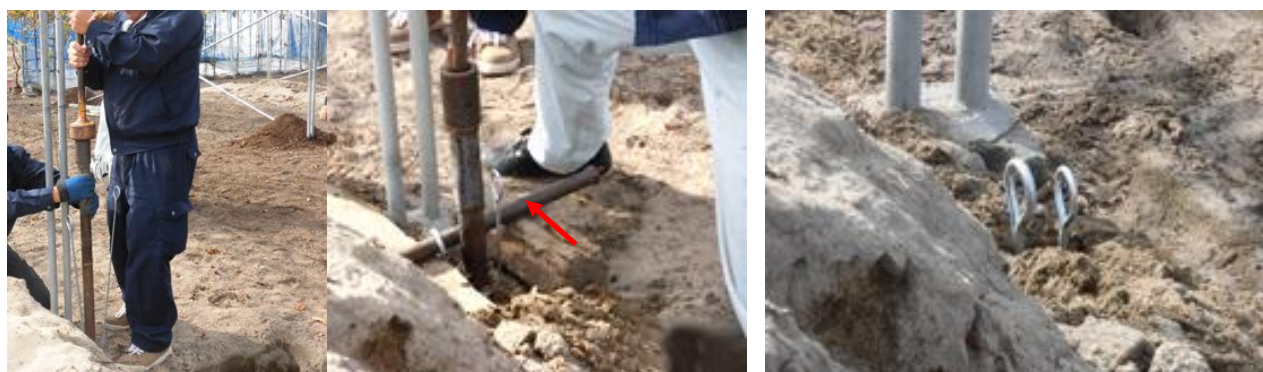
図31 補強に用いるアンカー
