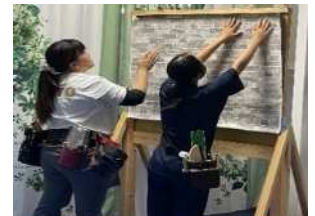
（壁紙貼り付け作業）
