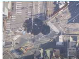
1月31日時点の事故現場の状況
