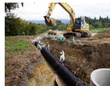
排水構造物工(暗渠排水管)
