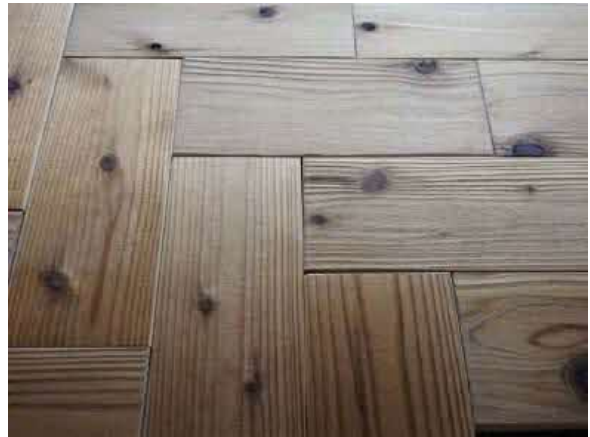
図4 短尺板による床の施工イメージ
