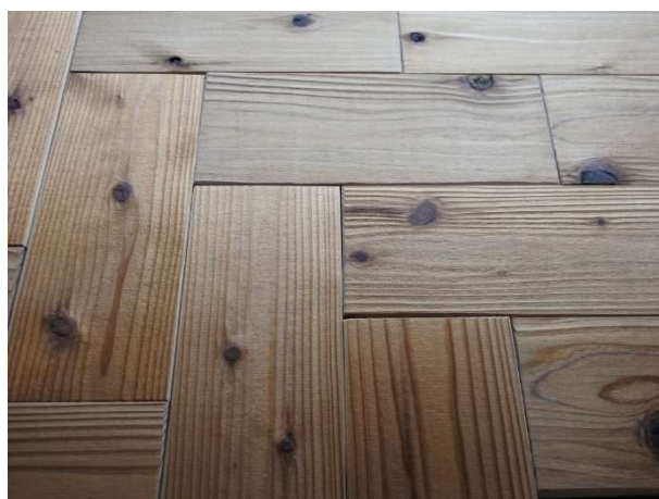
図4 短尺板による床の施工イメージ
