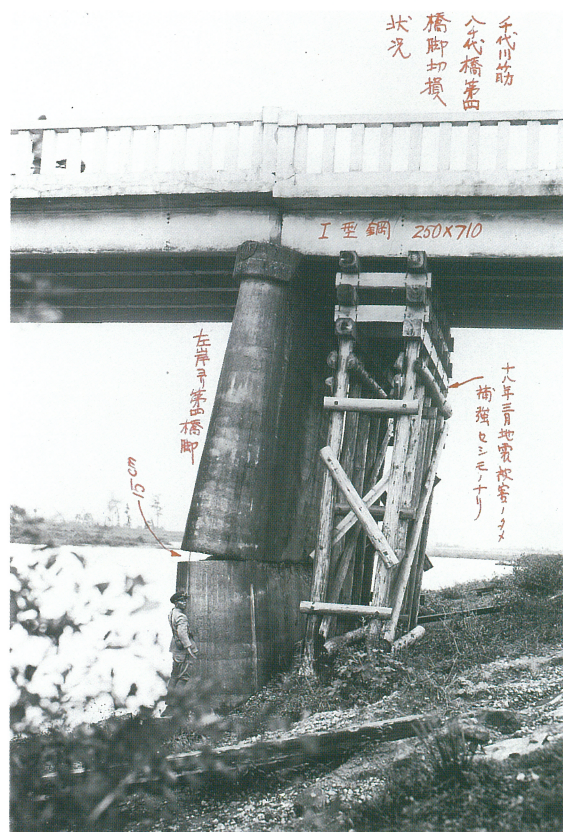
3月4日、5日の地震後に補強された八千代橋 (「鳥取地方震災被害調査報告書」)
