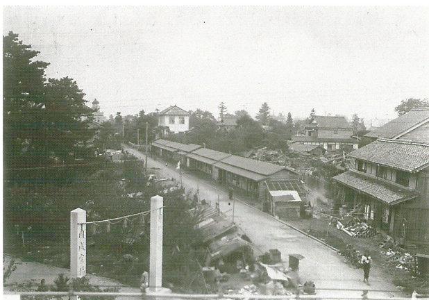
鳥取大神宮付近の仮設住宅
