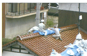
ボランティアによる棟瓦の破損部分へのブルーシート張り
