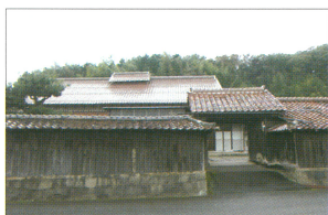
北栄町北条島地内の旧家。被害はなさそうであったが、その後に壁が剥落したという
