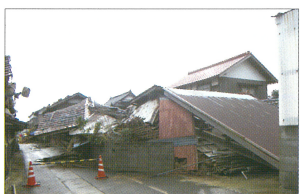
北栄町西園地内の倒壊家屋
