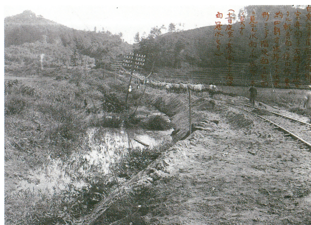
白兎一宝木間の陥没箇所の復旧工事 水尻池に沿うように敷設された箇所、水面は11日夜来の豪雨で冠水したものである。 (「鳥取地方震災被害調査報告書」)
