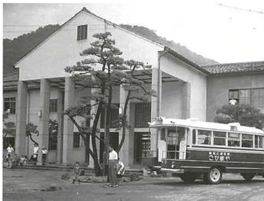
昭和19年建築の庁舎（3代目）
