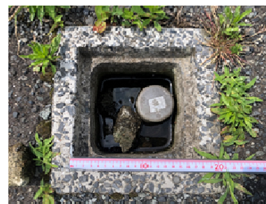
③智頭町大字智頭地内
