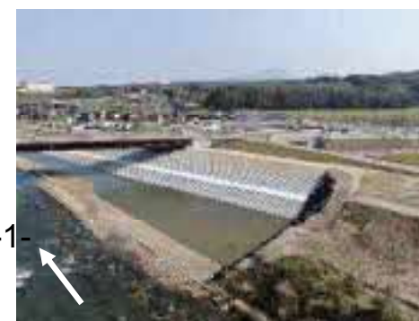
③吉定地区 護岸工事 R7.3.21撮影
