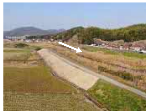
①大袋地区 堤防工事 R7.3.21撮影
