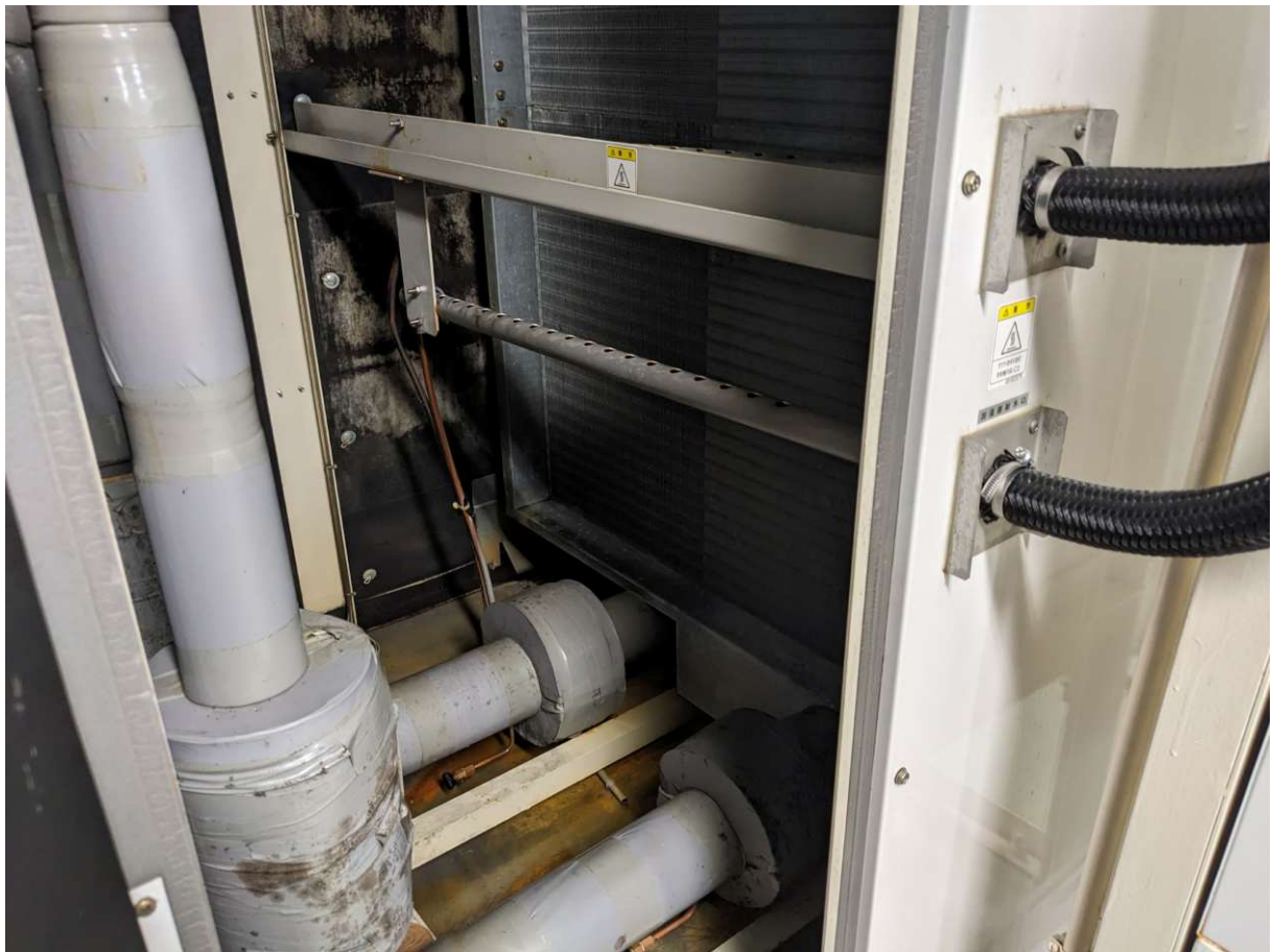
③-3 AC212第2展示活動室系統_空調機内蒸気噴霧管周り状況
