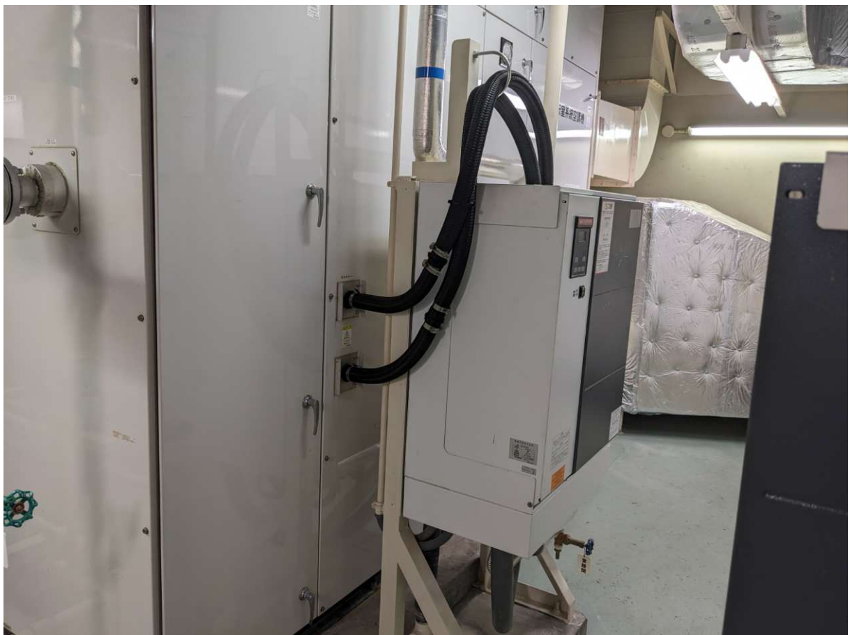
⑤-2 AC214第2特別展示室系統_蒸気加湿器設置状況
