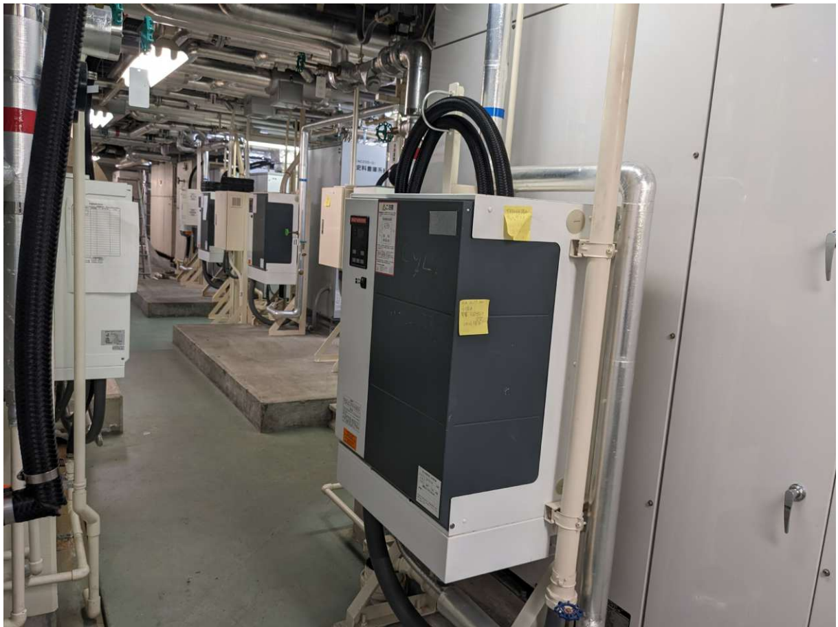
⑤-1 AC214第2特別展示室系統_蒸気加湿器設置状況
