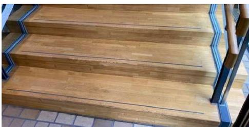
段鼻のステンレス部分が細く、段鼻の視認性が低くなっています。
