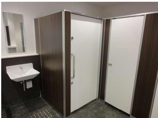
良い事例として、床面はマーブル模様の明度の低い黒色、壁面が明度の低い木目調、出入口戸は明度の高い白色とし、明度差と色相差による色のコントラストが設けられています。
