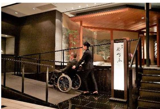
傾斜路の立ち上がりは明度の低い黒色に、傾斜部分は明度の高い灰色とし、明度によるコントラストを設けています。
