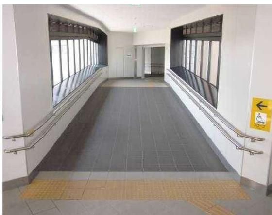
壁面は明度の高い白色とし、傾斜部分は明度の低い灰色と色のコントラストを設けています。また、前後の廊下等とは床面の色の明度を変更し、弱視者にもわかりやすいように配慮しています。色相による色のコントラストを確保した標識や点状ブロック等を設置しています。
