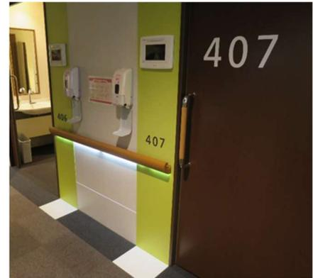
写真では、カーペットに塩ビタイルを埋め込み、触感と照明の反射、色の違いによる誘導を行っています。
