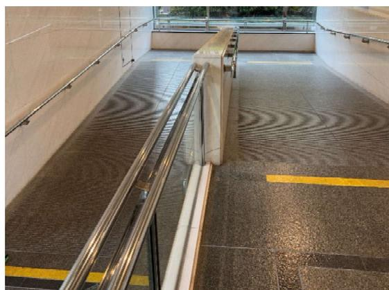
壁面は明度の高い白色とし、傾斜部分は明度の低い灰色と色のコントラストを設けています。
