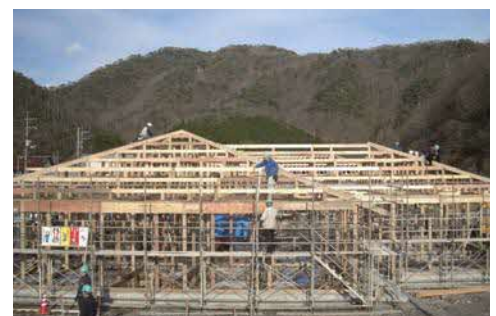
木を使って建物を建てている様子
