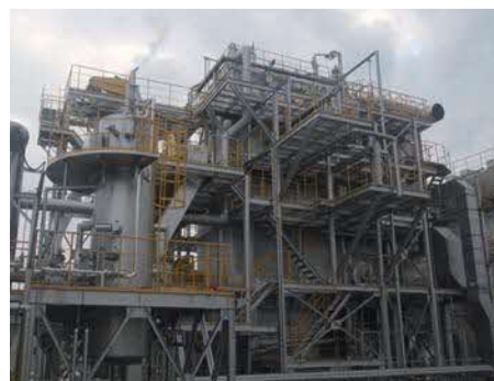
にっしん 日新バイオマス発電所(境港市)
