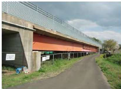
東北自動車道 大森川橋
