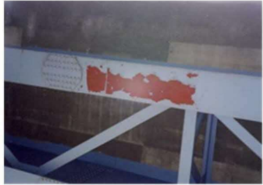
部分的に防食皮膜が剥離し、下塗りが露出している。
