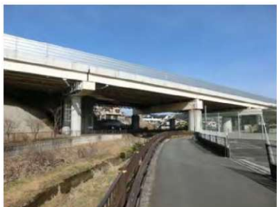
中央自動車道 城山川第二橋
