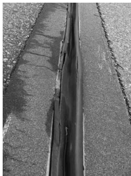
(ゴム) ひびわれが生じている。
