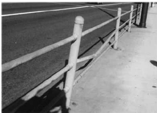
部材が局所的に変形している。
