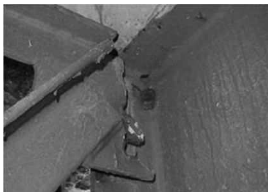
対傾構が破断している。
