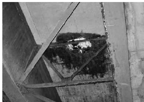
コンクリート塊が抜け落ちている。
