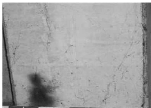
錆汁を伴う漏水が生じている。
