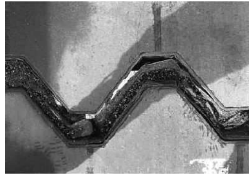
(その他) 伸縮装置の目地材が剥がれている。
