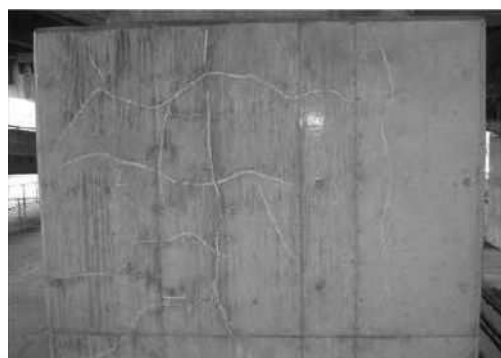
軽微なひびわれが生じている。
