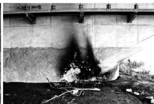
たき火による損傷
