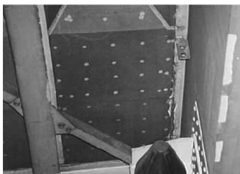
うきは発生していないものの、シーリング部が一部剥離し、錆及び漏水が見られる
