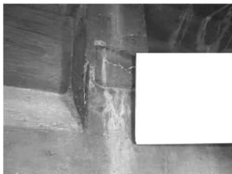
ひびわれからの錆汁を伴う漏水
