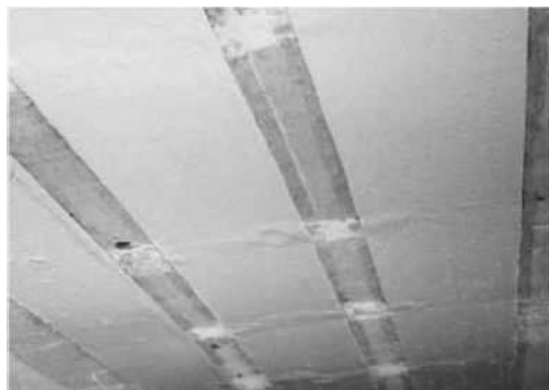
軽微なうきが生じている。補強部材から遊離石灰が生じている。
