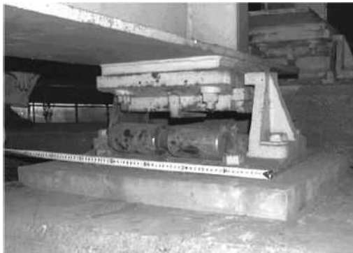
パターン 3 支承ローラが脱落している。
