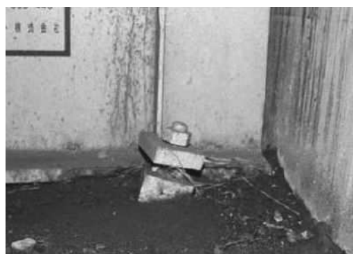
パターン 6、7 支承の傾斜 大量の土砂堆積
