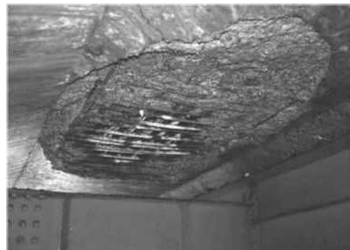
コンクリート塊が抜け落ちている。
