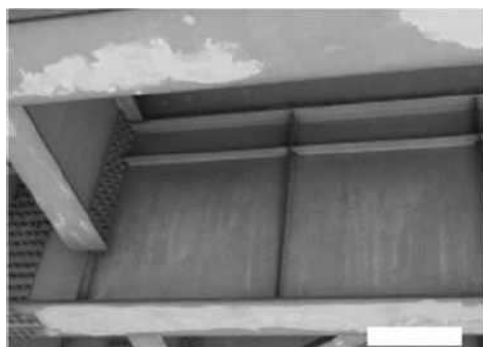
最外層の防食皮膜が変色している。
