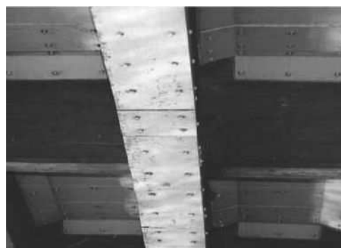
うきは発生していないものの、錆が見られる。
