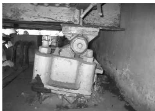
支承が沈下・傾斜している。
