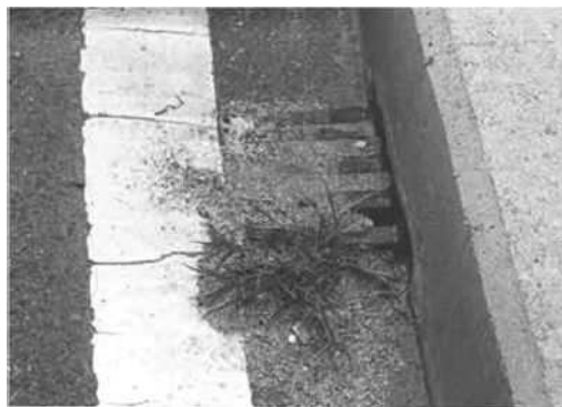
排水桝に土砂詰りが生じている。
