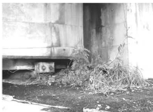
支承周辺に土砂詰りが生じている。
