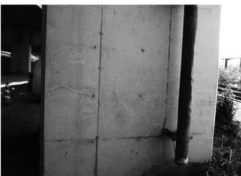
軽微なひびわれが生じている。
