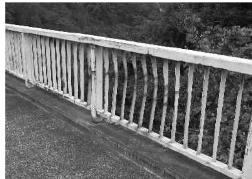
部材が局所的に変形している。
