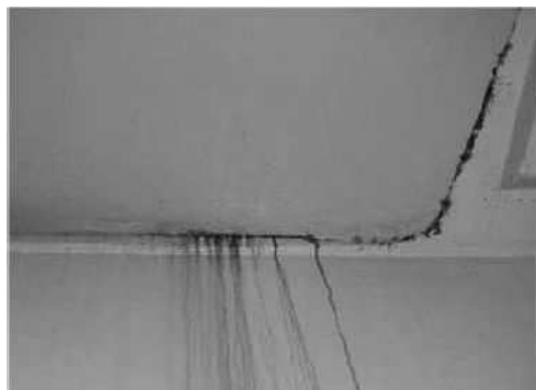
錆汁を伴う漏水が生じている。
