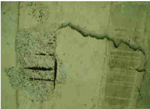
鉄筋が露出しているが、局部的であり鉄筋の腐食は軽微である。
