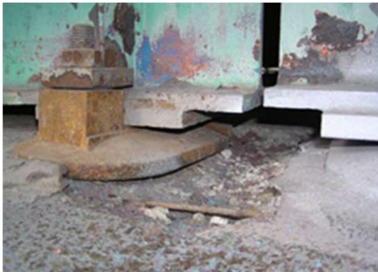
パターン 1 荷重支持機能が損なわれている。
