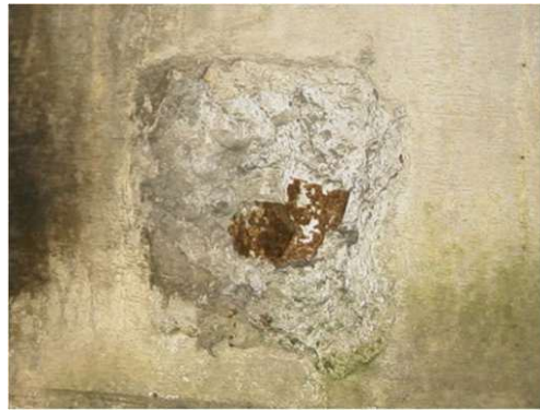
定着部のコンクリートが剥落、定着部の腐食
