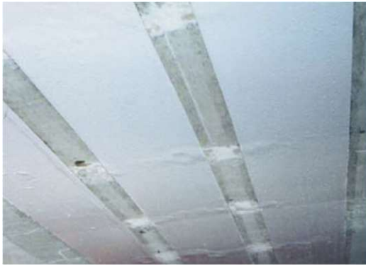
軽微なうきが生じている。補強部材から遊離石灰が生じている。
