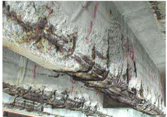
鉄筋が露出しており、著しく腐食している。
