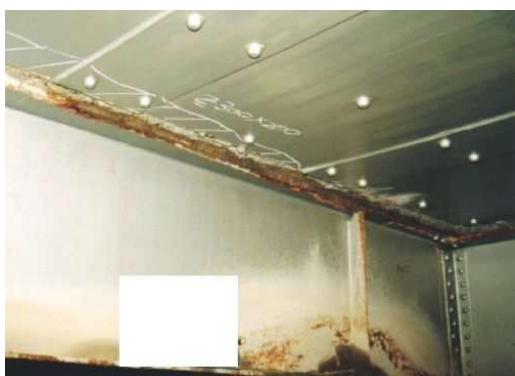
顕著なうき、腐食及び漏水が生じている。
