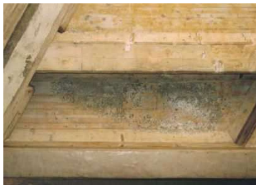
(コンクリート) 黄色っぽく変色している。
