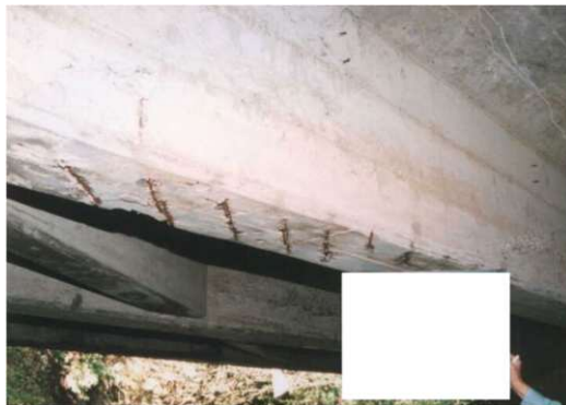
鉄筋が露出しており、鉄筋の腐食は軽微であるが、広範囲に生じている。
