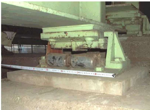
パターン 3 支承ローラが脱落している。
