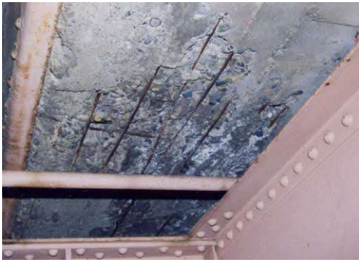
鉄筋が露出しており、著しく腐食している。
