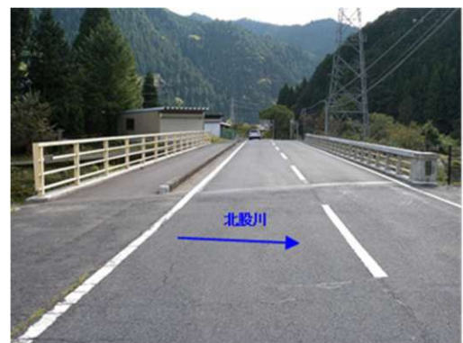
終点側→起点側
