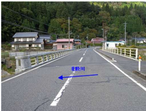
起点側→終点側
