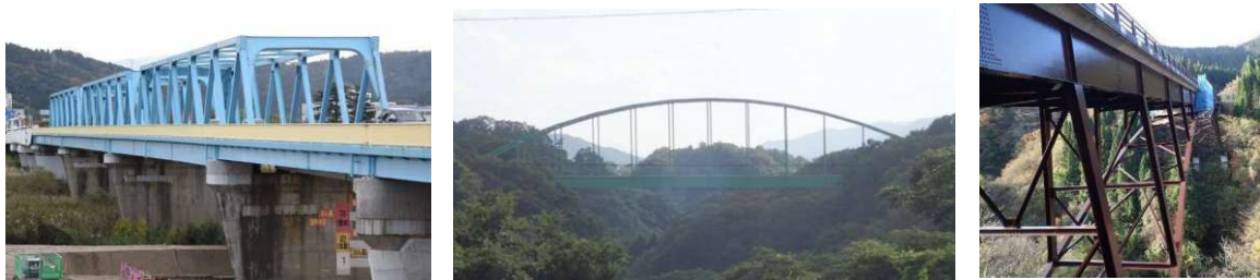
天神橋：トラス（下路）
