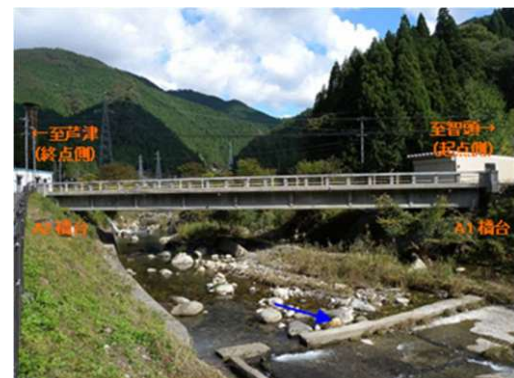
下流側→上流側
