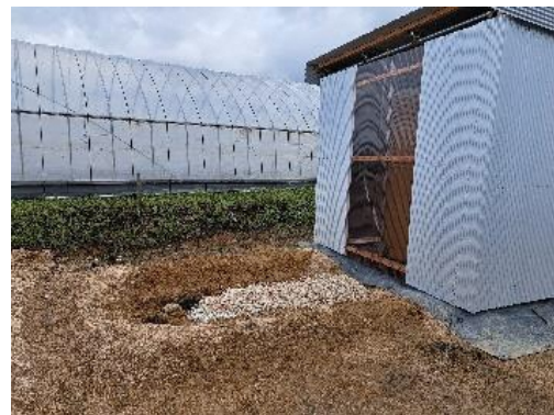
新設した簡易トイレの外観
