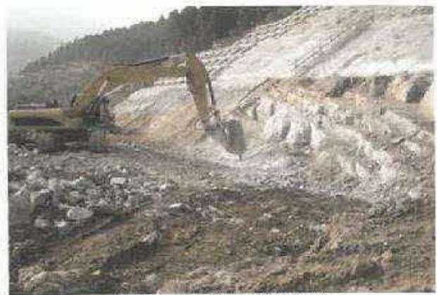
大型ブレーカによる掘削作業状況
