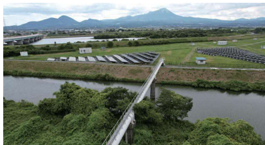
2026.8 法勝寺水管橋と大山
