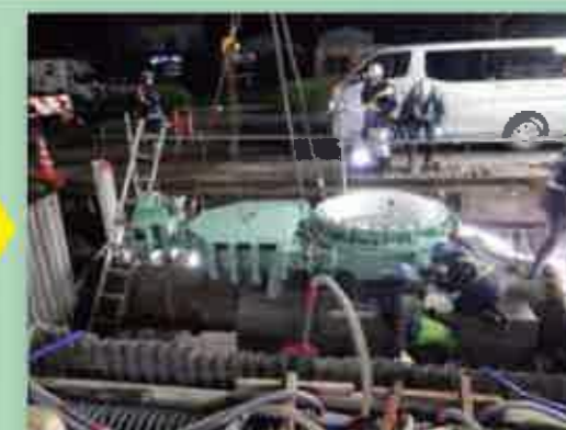
作業するための台を設置します。
