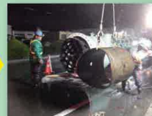
切った管です、見事に抜けました 水を通しながら切るので穴あきカッターです
