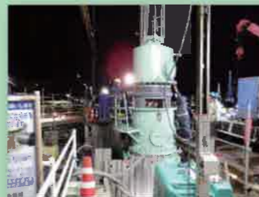
切った部分に分岐弁本体を挿入します 慎重にセットします
