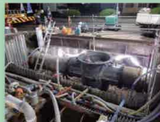
管の外側にカバーを設置します。 車線規制を行い夜間工事で実施しました。
