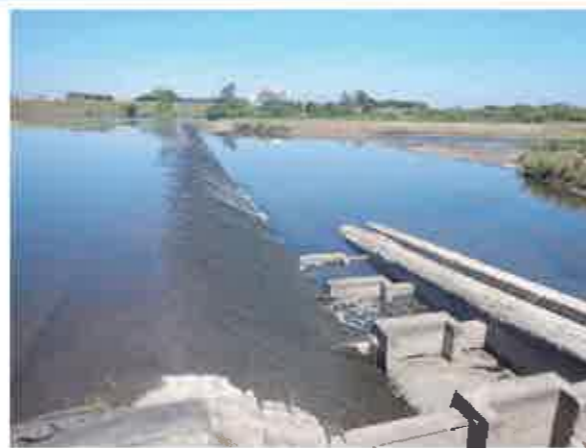
R6.6.7の車尾堰(国交省資料より)
