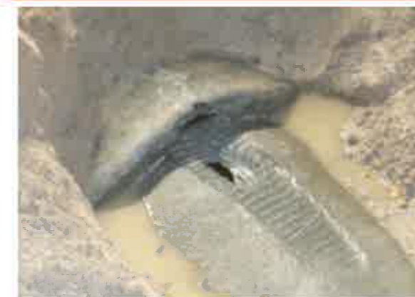
管破損状況
