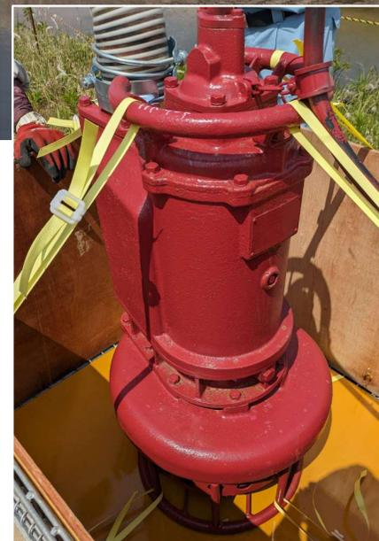
水中サンドポンプは、河床の砂の吸い込みを抑制するため、周囲をコンパネで囲った吊りパレットの中に固定し、それを河床に設置することとした。
