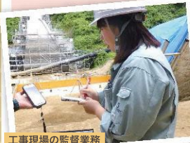
工事現場の監督業務
