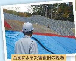
台風による災害復旧の現場
