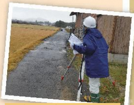
給水栓設置工事における測量業務
