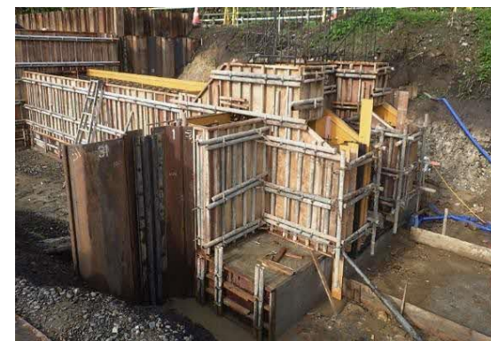
型枠工（省力化構造）
