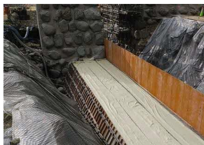
仮締切工 (砂防コンクリート締切)
