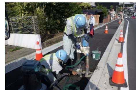
舗装版削孔工
