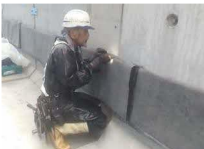
排水材設置工
