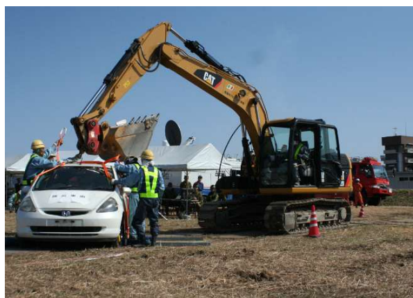
写真 バックホウによる吊上げ移動（イメージ）
