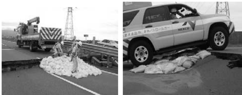
※新潟県中越地震における段差の復旧状況の例（吉井川橋 橋台上り線）
