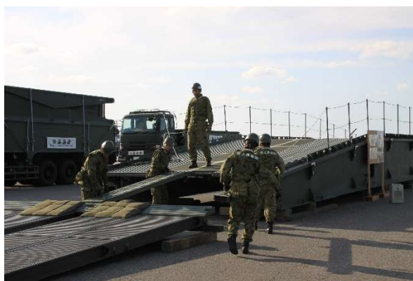
陸上自衛隊による応急訓練 (支援橋の架設)
