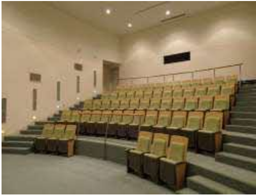
梨シアター系統：AHU-M-3 製造・機種：新晃工業 AJ80-MX 設置箇所：空調機械室(P2-2)
