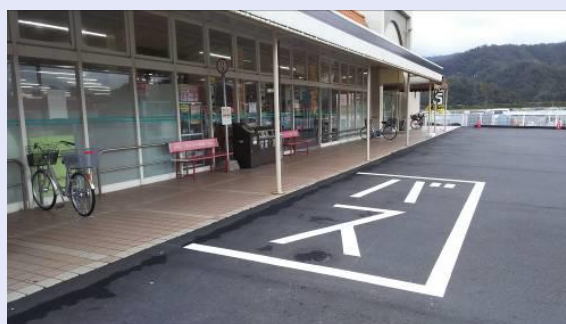
施設内でバスを待つことのできる例 (岩美町内の商業施設)
