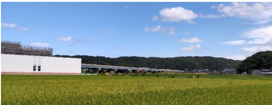
写真 1 建設中の展示ガイダンス施設(R4.9)と奥に鳥取西道路とその右側古代山陰道が越えていた養郷宮之脇遺跡付近の斜面
