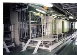
◆ 水だけを透過する半透膜(RO膜)で浸出水を加圧ろ過する処理方式
